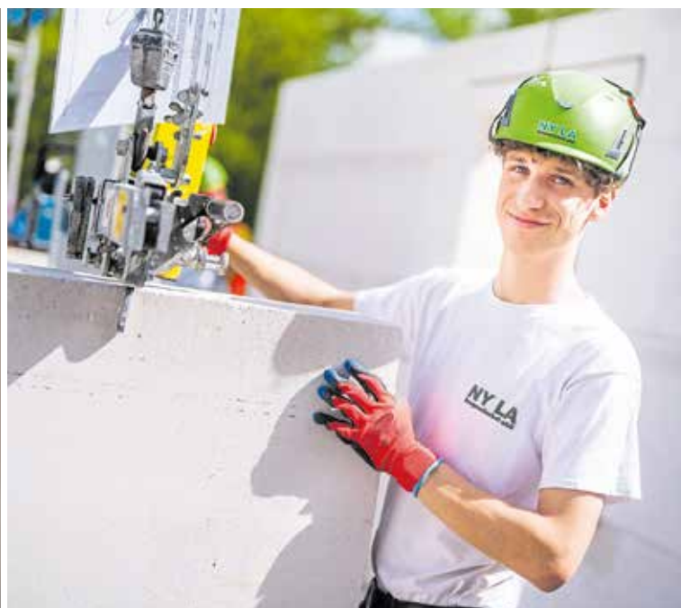
Fabio Noack lernt mit ihm gemeinsam. Auf der Baustelle können beide schon richtig mit anpacken – wie bei der Oberlausitzer Sporthalle in Rietschen.
